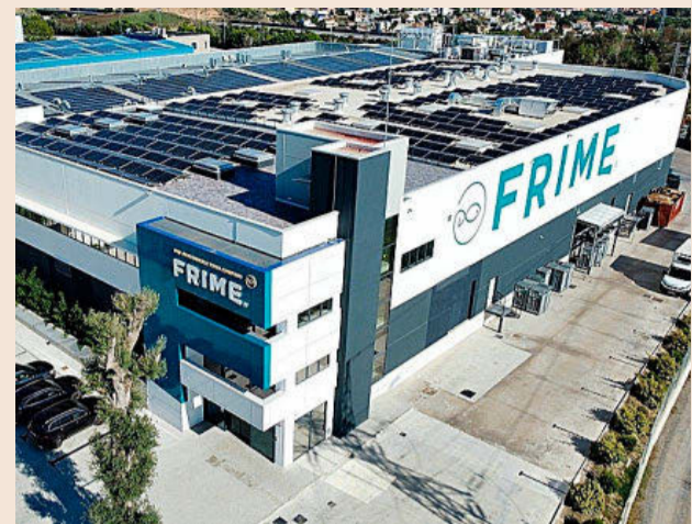
Planta de Frime en La Roca del Vallès (Barcelona).
